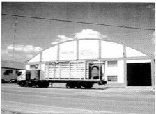
IMAGEN DE LAS AMPLIAS INSTALACIONES DE 'HIDROTEC'
